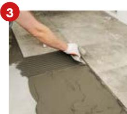
Extienda el adhesivo con el lado liso de la llana y con el lado dentado, haga surcos en una sola dirección. La extensión del adhesivo no debe ser muy grande, para que no se seque antes de pegar las piezas.
