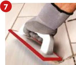
Rellene las juntas con una plancha de hule, realizando movimientos diagonales en los azulejos.
