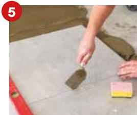
Luego de 24 horas, limpie las juntas de cualquier partícula de adhesivo. Realice la mezcla del relleno para juntas Sisatec.
