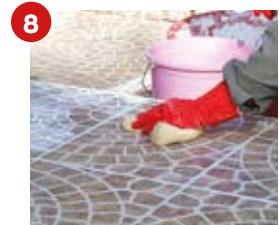
Conforme se rellene, se recomienda remover el excedente con una esponja húmeda, hasta dejar limpia el área instalada.
