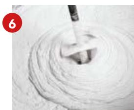
Mezcle 3 litros de agua por saco de 10kg. Advertencia: si se agrega mucha agua, el color se diluirá y puede generar burbujas de aire; La consistencia puede causar desprendimientos.
