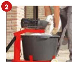
Mezcla: de 5.0 a 5.5 litros de agua limpia por bulto de 20 kg. Rendimiento: hasta 5mts2 por bulto de 20 kg. (Varía en función del sustrato de aplicación y del tipo de llana utilizada).
